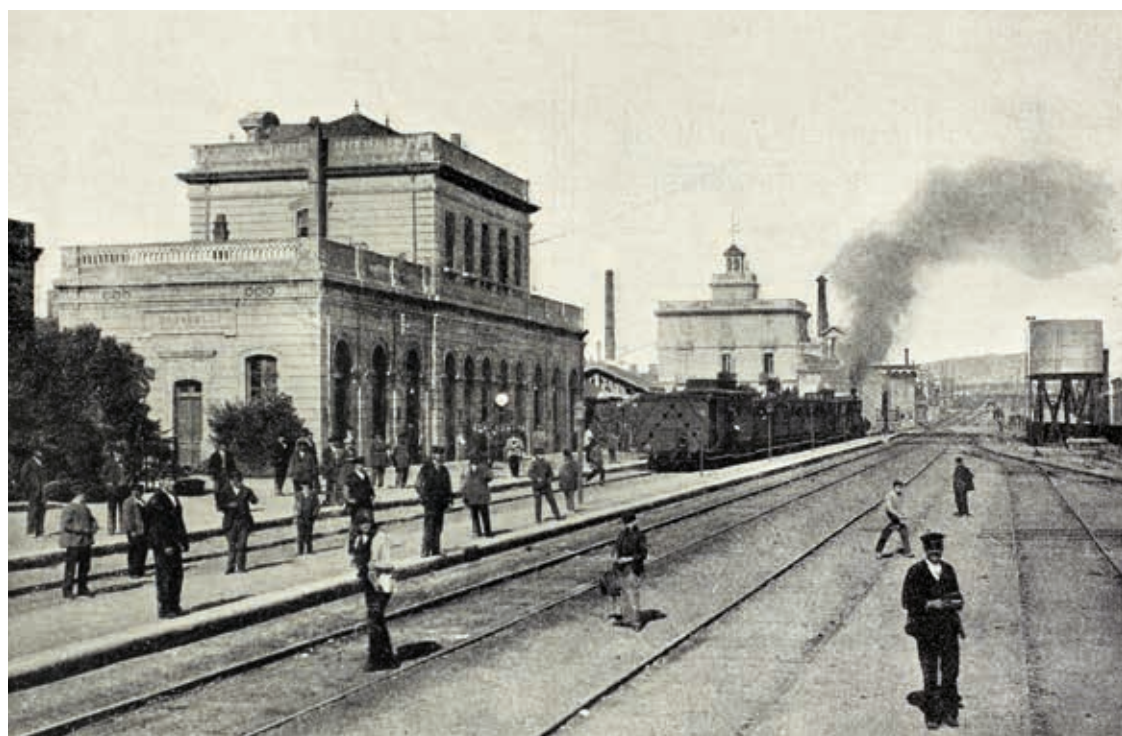
En aquesta pàgina, a dalt, un tren impulsat per una màquina de vapor a l'estació del Nord entre el 1900 i el 1903. A baix, una vista general de l'esmentada estació publicada al Portfolio Anunciador de Sabadell el 1898.
